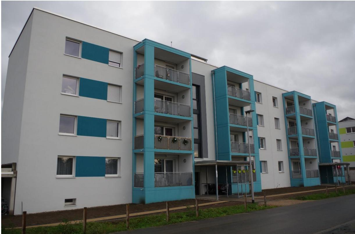
Denn der Großteil des Bedarfs wird jetzt durch andere Verfahren gedeckt, sagen die Sanierer. Sonnenkollektoren auf dem Dach, eine 20 Zentimeter starke Dämmung, eine Wärmepumpe, die ihre Energie aus drei Erdsonden ins Haus fördert: „Im Jahresschnitt kann das reichen, um den Energiebedarf zu decken“, sagt Dieter Wolf. Wer mehr braucht, zahlt zu.
